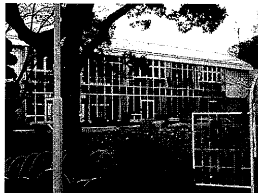
(写真2 事件後改修された体育館)
