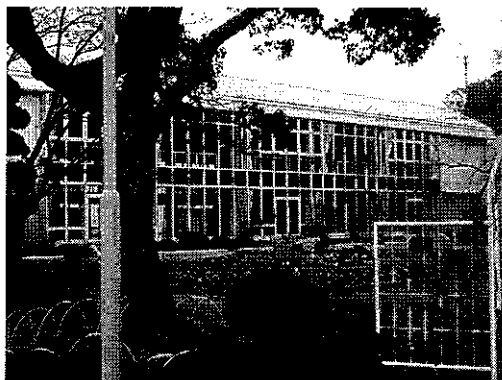
(写真2 事件後改修された体育館)
