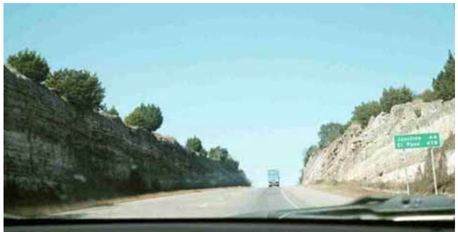
図7 Interstate Highway 10 沿いの切り通し斜面 Sonora 付近
