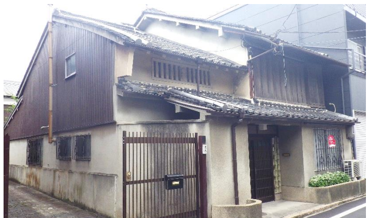
一階が全面的に改装された町家
